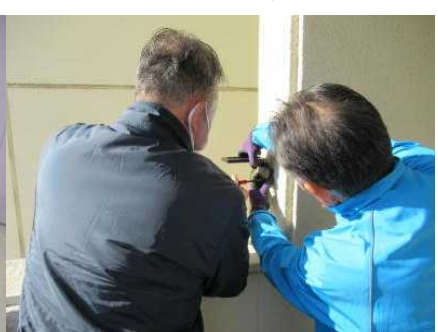
団体側出入口ソーラーライト設置
