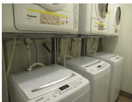
洗濯乾燥機用排水ホースセット取付
